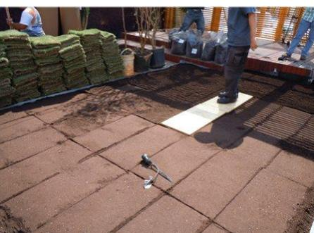
4. Aplicação do substrato em camada na espessura desejada
